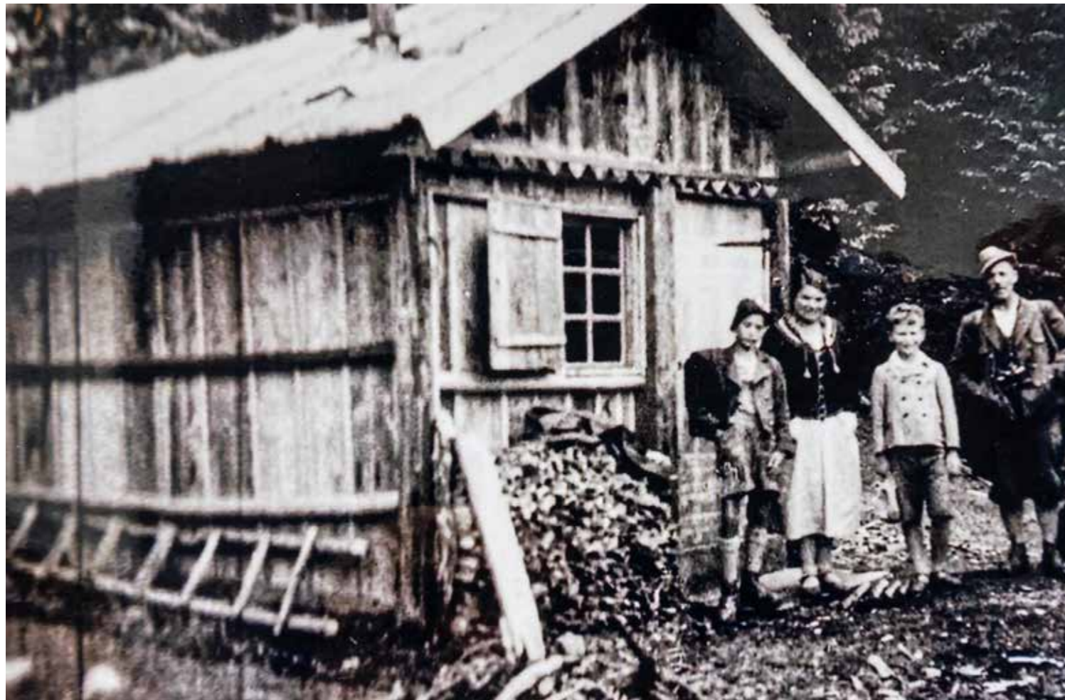
Nach dem Abschied der Grenzaufseher dienten manche von deren Wachhütten als Unterkünfte für Einheimische.
